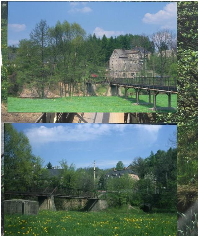
Die hölzerne Rampe als Stegverbindung zwischen dem Hochwasser-Damm und Brücke blieb zunächst bestehen und führte wie bei der hölzernen Stegbrücke hin zu dem noch ganz in der Nähe befindlichen Hochwasserschutzdamm. In den drei Bildern ist allerdings bereits der Schutzdamm zurückgesetzt und die Rampe verlängert worden.
