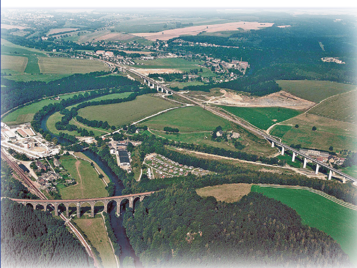
Blick auf die Neubautrasse mit ihren zwei modernen Stahlbetonbrücken (im Bild rechts) in der Bauphase. Im Vordergrund links der Hetzdorfer Viadukt und die damaligen Baustelleneinrichtungen. Außerdem im Bild: Die Strecke der Erzgebirgsbahn von Chemnitz über Flöha nach Olbernhau-Grünthal bzw. Marienberg über Pockau-Lengefeld.
