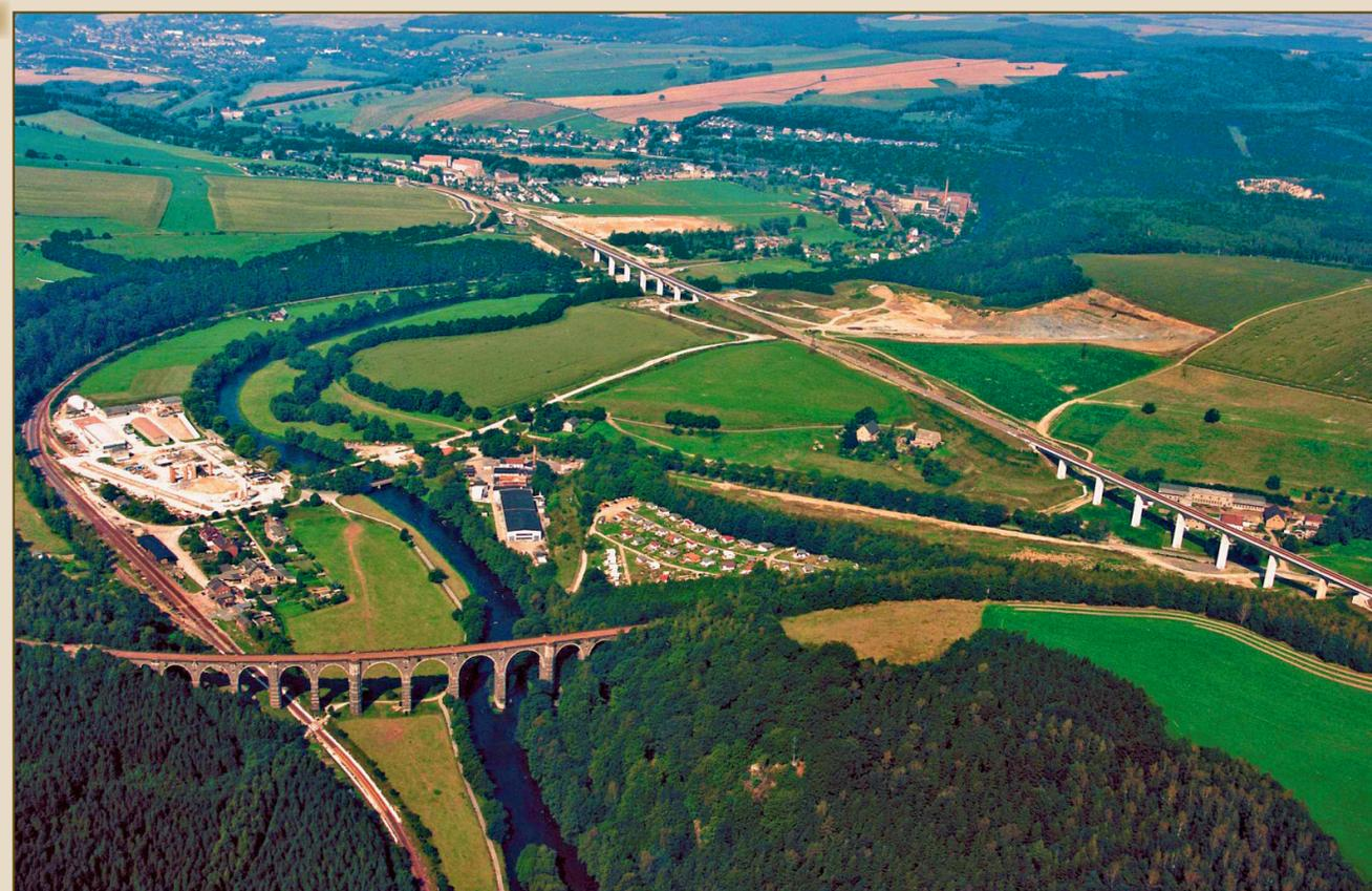
*Eine historische Luftaufnahme während der Bauarbeiten an der Neubautrasse mit ihren beiden Stahlbetonbrücken (im Bild rechts und oben links). Als moderne Zweckbauten können sie dem historischen Hetzdorfer Viadukt (im Vordergrund links) in puncto Schönheit und Eleganz natürlich nicht das Wasser reichen.*
