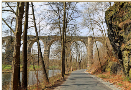
Blick auf das Hetzdorfer Viadukt von der Talstraße in Richtung Falkenau.
