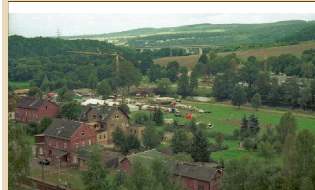
Blick auf den Veranstaltungsort des Brückenfestes 1999 (in der Bildmitte). Das Foto wurde vom Hetzdorfer Viadukt aus aufgenommen. Im Vordergrund der Blick auf den Bahnhof Hetzdorf/Flöhatal, Kreuzungsbahnhof der Erzgebirgsbahn zwischen Chemnitz und Olbernhau. Im Hintergrund ist die Brücke der Neubautrasse über das Flöhatal zu sehen. Der Kran in der Bildmitte verweist darauf, dass der Neubau der Straßenbrücke über die Flöha im vollen Gange war.
