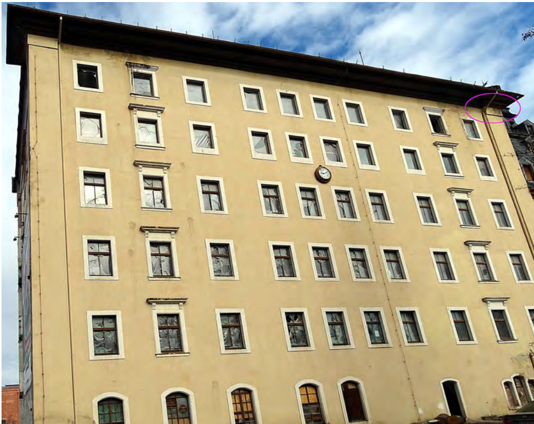
Bild 12: Parkfassade des Altbaues 1826
