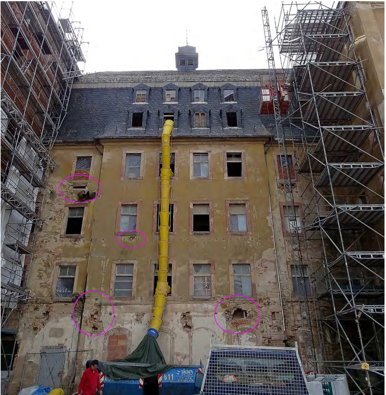
Bild 5: Fassade des Altbaues aus 1809 auf der Hofseite, Nischen beispielhaft markiert
