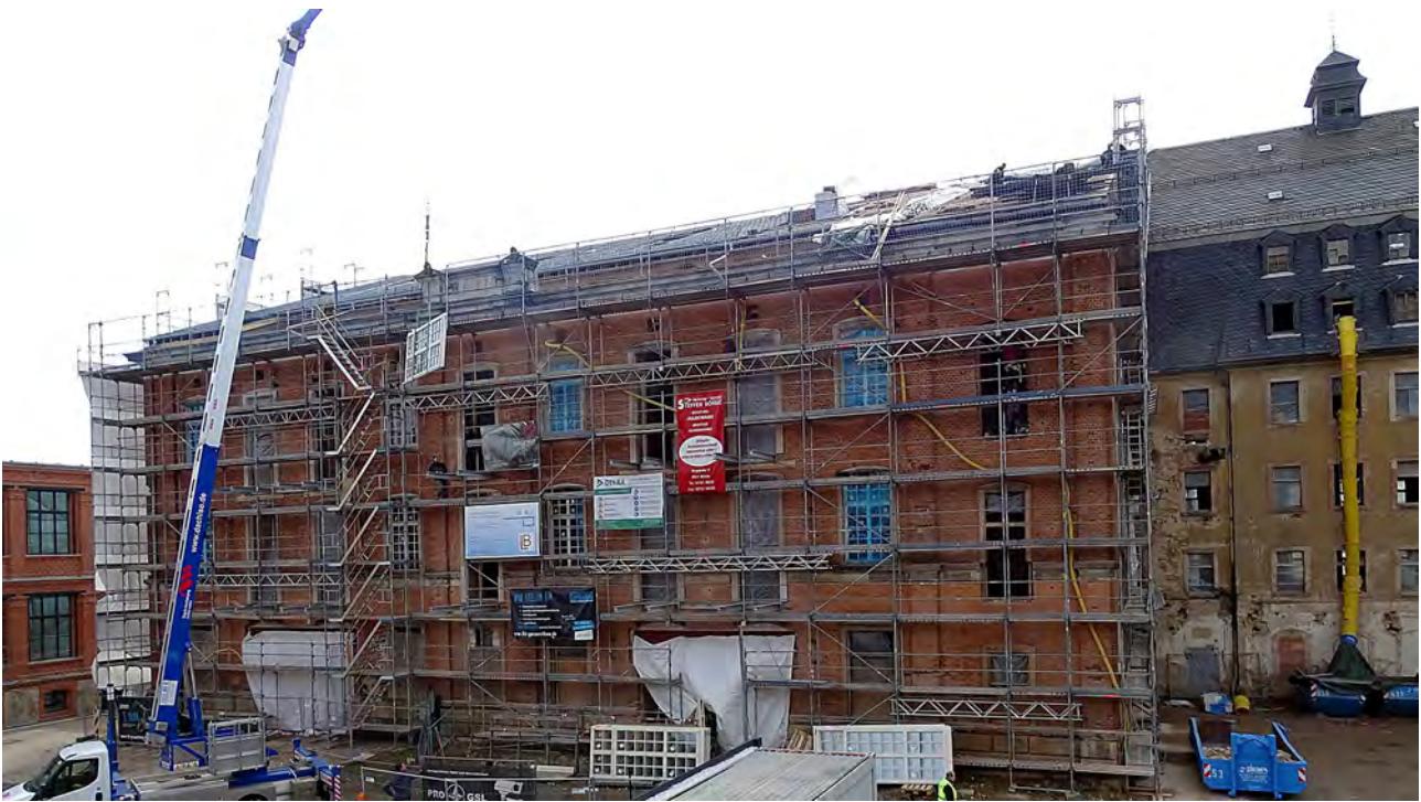
Bild 1: Blick von der Hofseite auf den Altbau (links Teil aus 1887; rechts Teils aus 1809)
