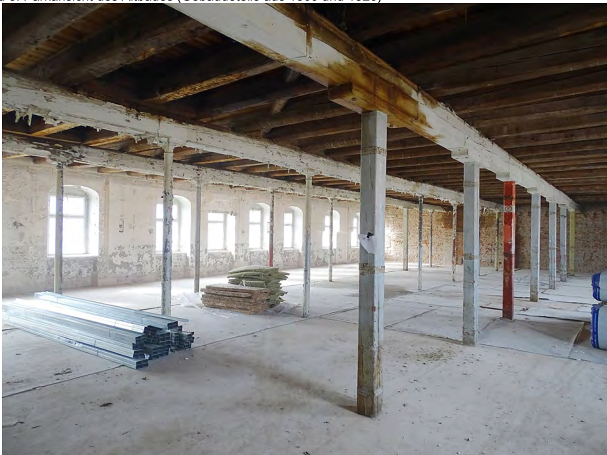
Bild 4: Maschinensaal im Altbau aus 1826 - innen entkernt
