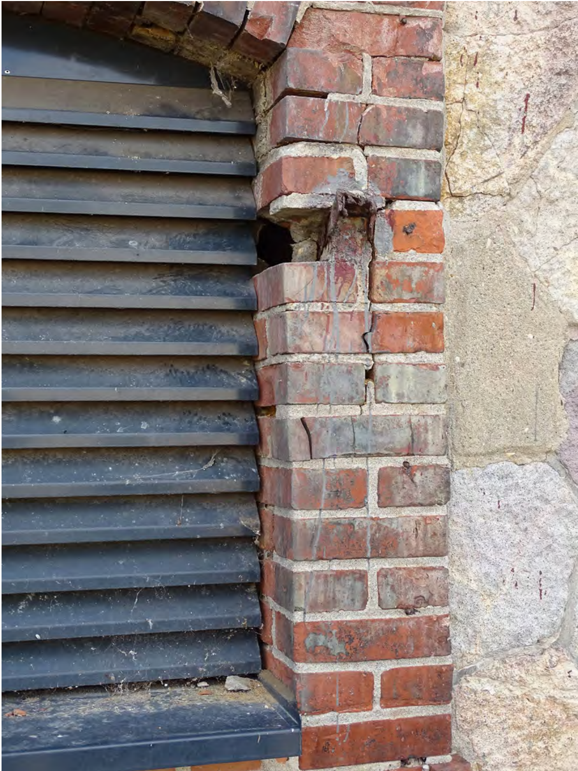
Öffnung ins Gebäude auf der Wasserseite der KitaLage des Turmfalkennistplatzes am Treppenhaus des Altbaues
