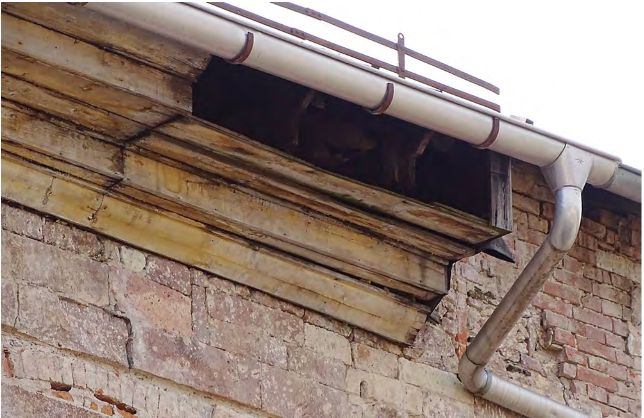
Bild 8: offener Dachkasten am Altbau 1826 auf der Hofseite
