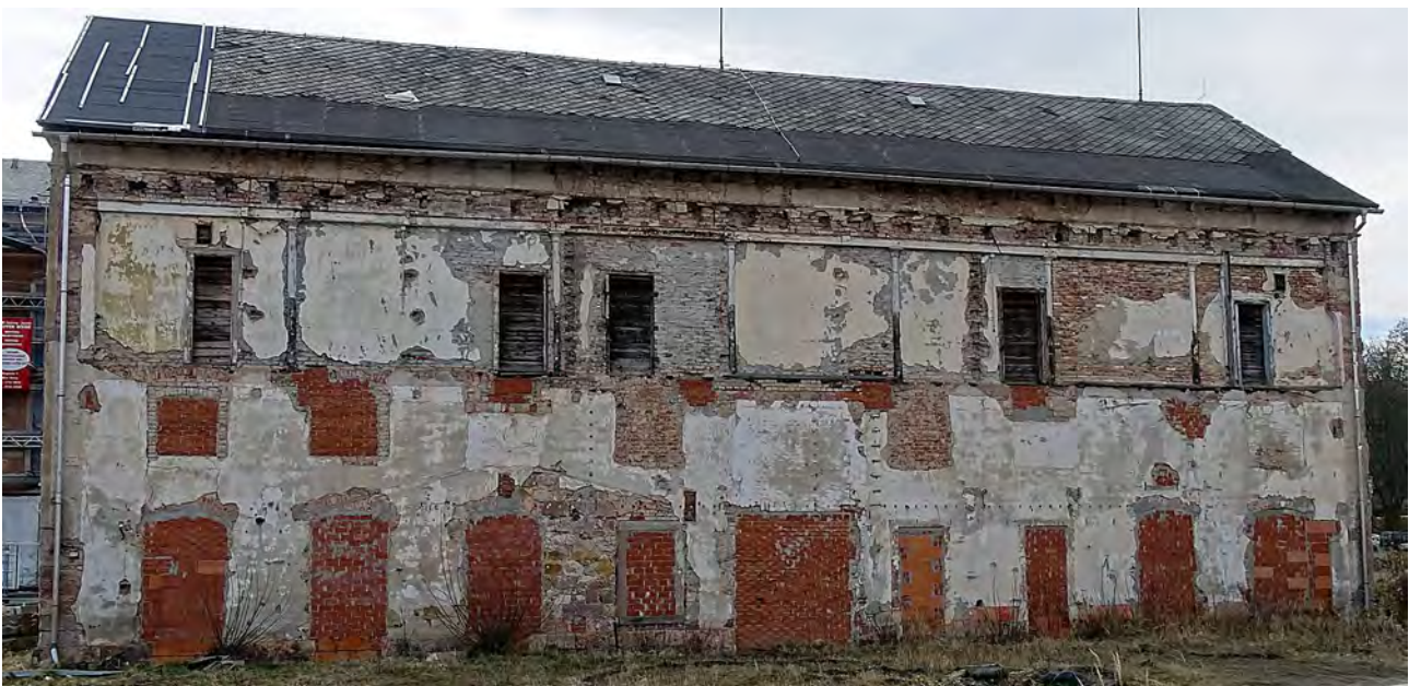
Bild 27: Nordfassade des Oederaner Baues mit zahlreichen Nischen oberhalb des Obergeschosses
