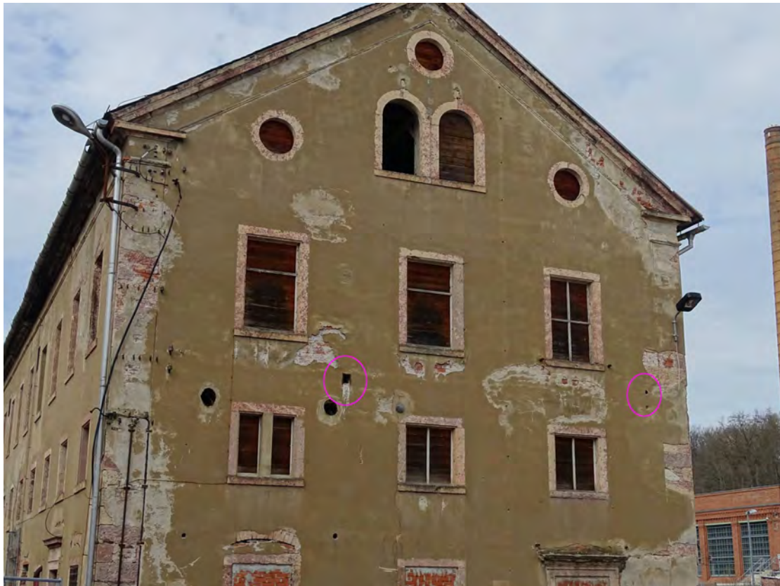
Bild 24: Ostgiebel des Oederaner Baues mit Nische mit Vogelkot und Bohrungen (markiert)
