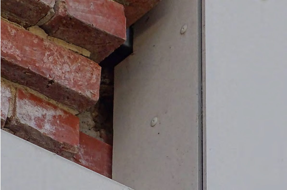
Öffnung, durch die Vögel oder Fledermäuse hinter die Verkleidung auf der Wasserseite gelangen können
