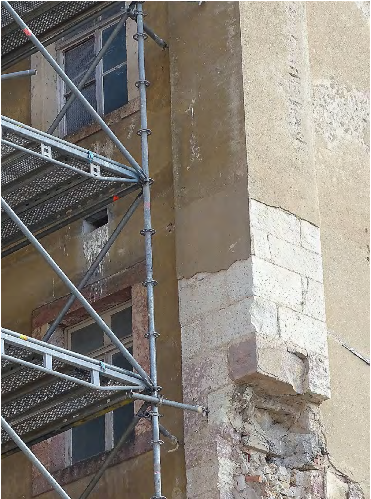
Lage des Turmfalkennistplatzes am Treppenhaus des Altbaues
