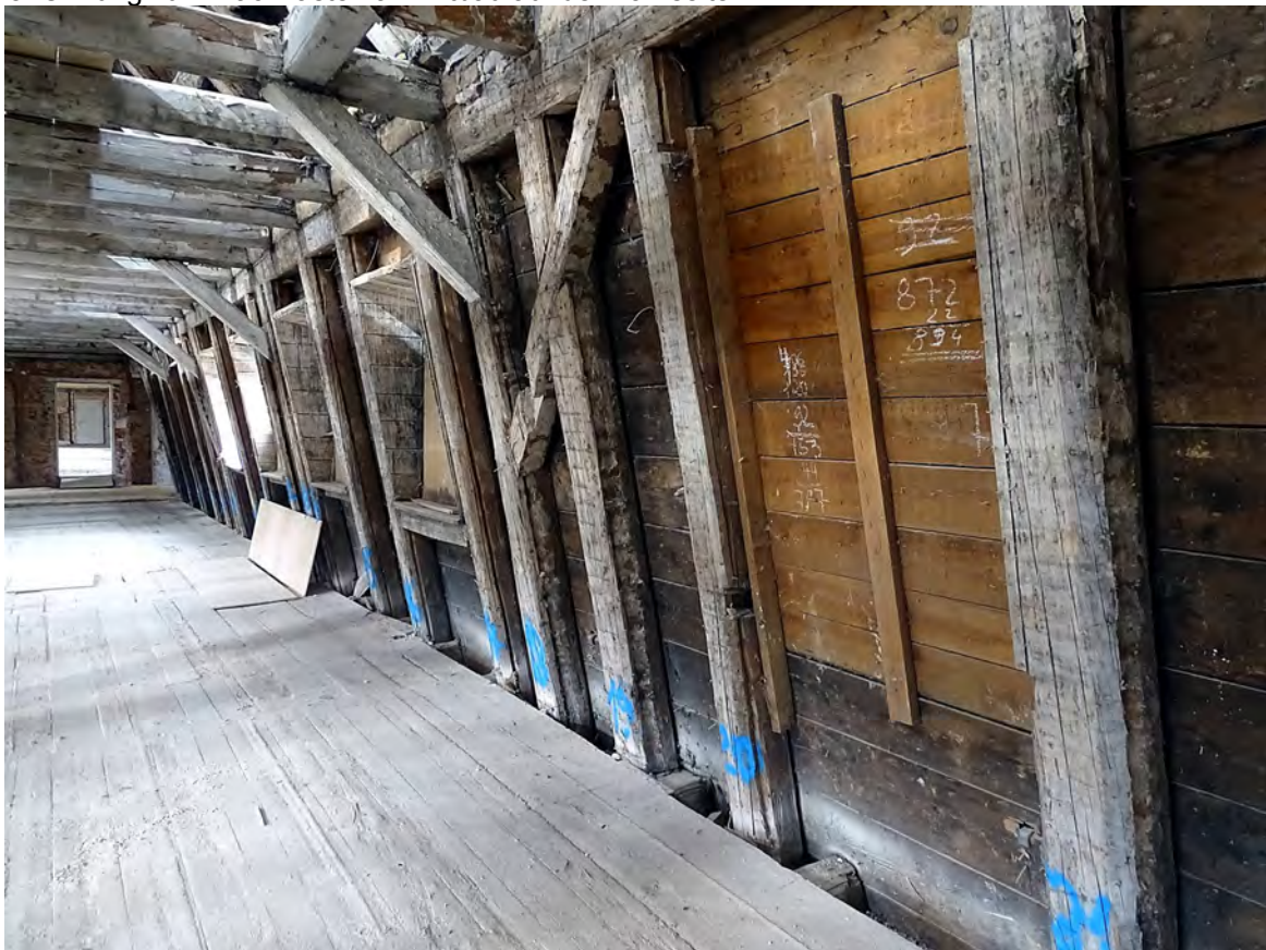
Bild 14: Dachgeschoss des Altbaues innen
