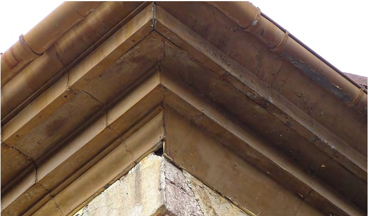
Bild 13: Öffnung zum Dachkasten am Altbau auf der Parkseite
