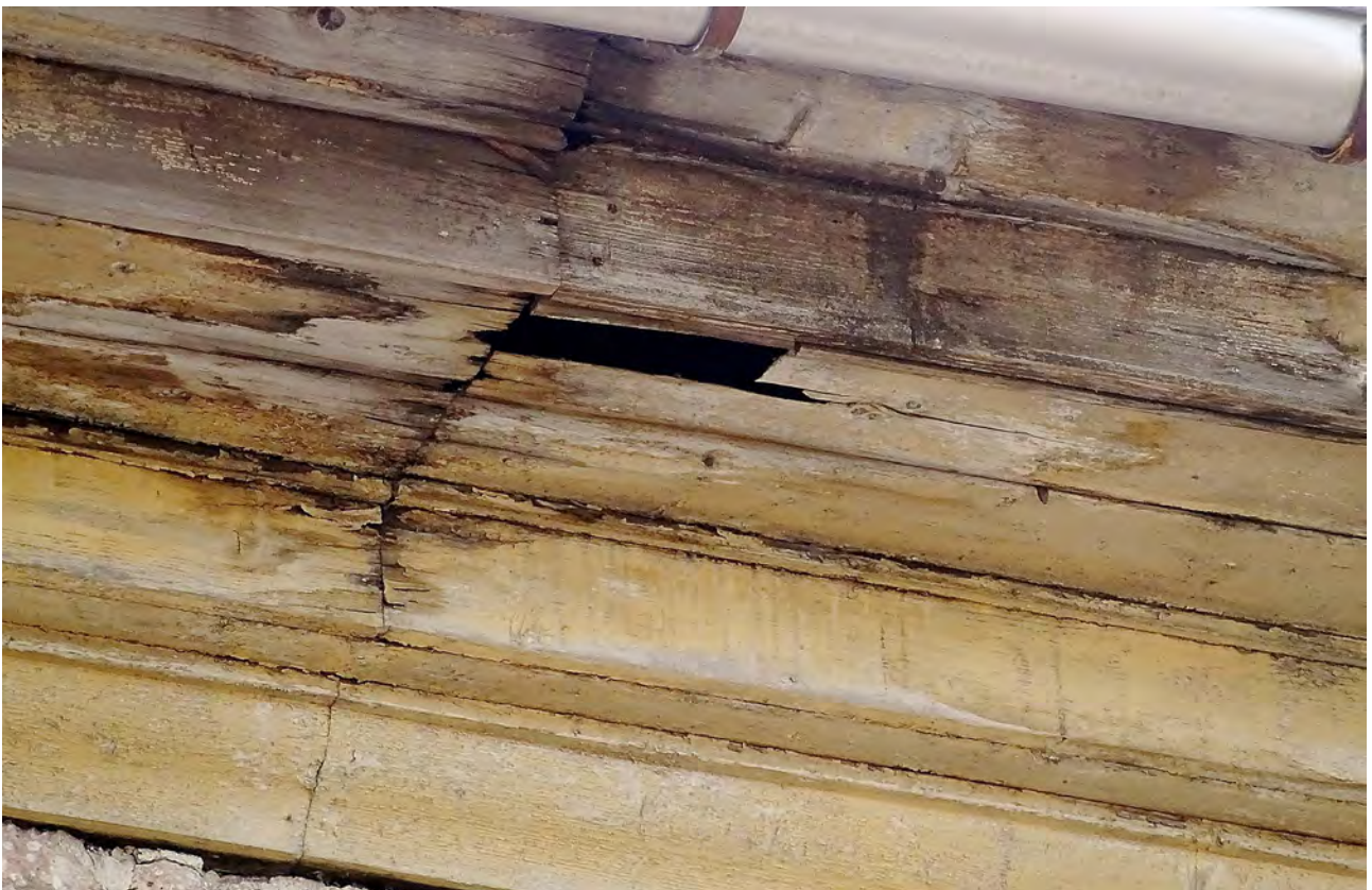
Bild 9: Öffnung im Dachkasten auf der Hofseite des Altbau 1826
