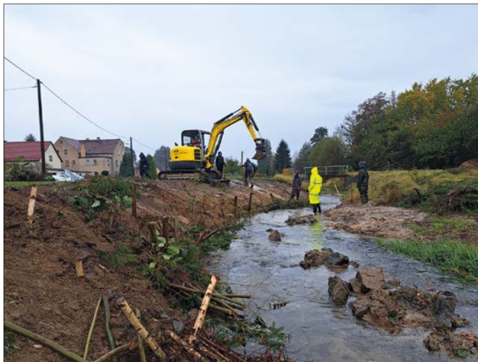
Bereits im nächsten Jahr werden hier die Gehölze austreiben und einen naturnahen Ufersaum bilden. Foto: Wetzelt, LfULG
