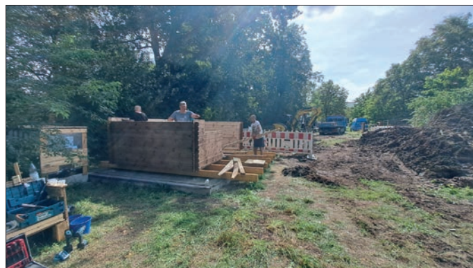
Abbau Gartenhaus. Foto: AWO Quartiersmanagement Flöha-Sattelgut
