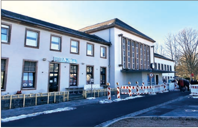
Der Bahnhof Flöha wird aktuell saniert. Foto: Knut Berger
