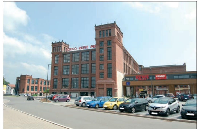
Der Neubau nach der Sanierung
