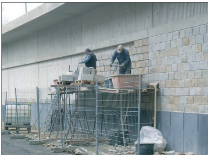
Anbringen der Natursteinverkleidung entlang der Dammstraße
