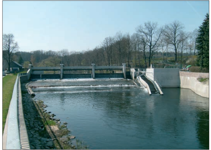
Saniertes Wehr und Wasserkraftanlage
