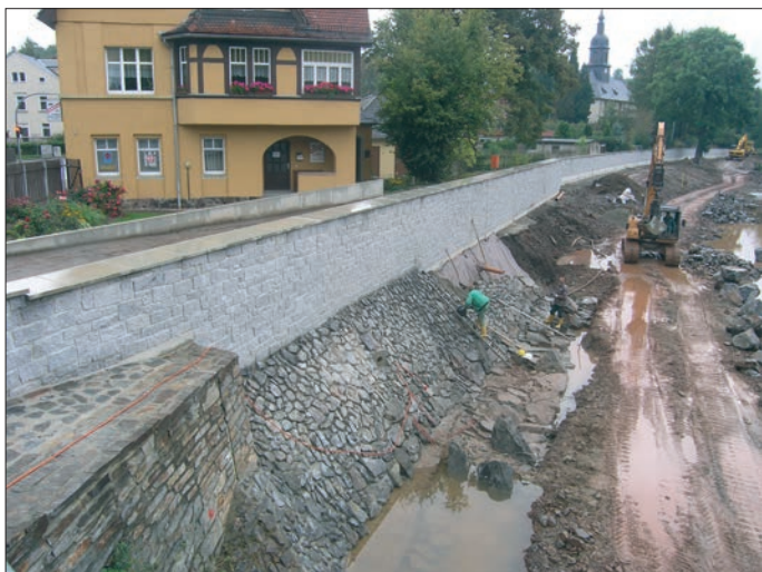
In Bau befindliche Schutzmauer oberhalb der alten Kirchenbrücke
