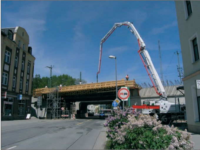
Die Straßenbrücke an der Augustusburger Str. wird gegossen
