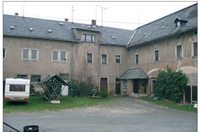
Die zur Erdmannsdorfer Str. gelegenen Gebäude 2004
