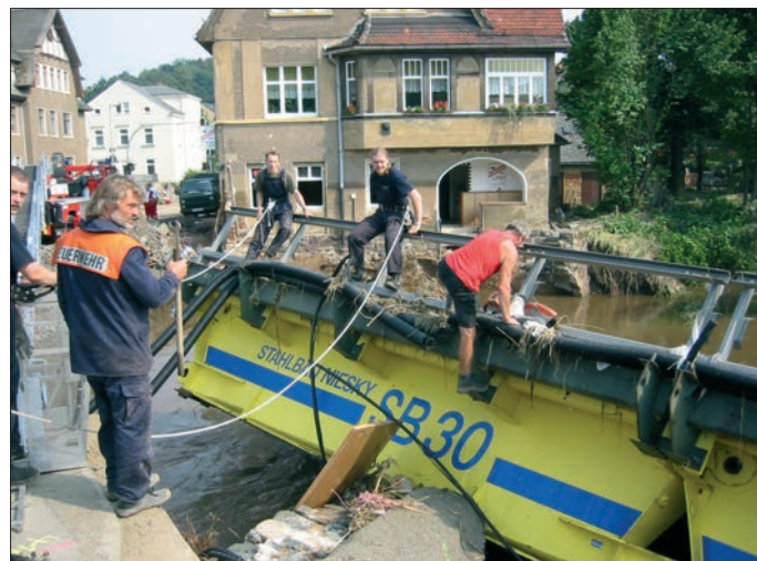
Einsatzkräfte bei der Bergung der Behelfsbrücke
