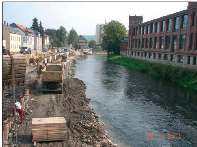
Bauarbeiten an der Zschopau an der Baumwollspinnerei
