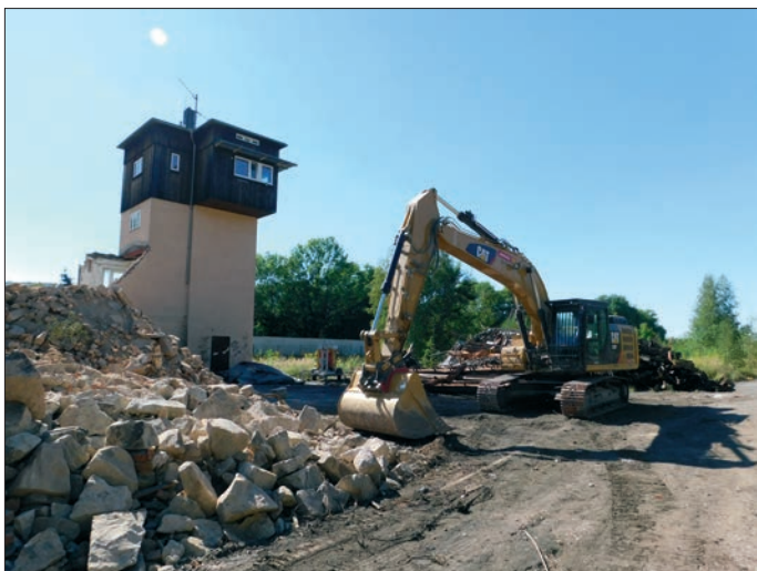
Abbruch Heizhaus und Befehlstellwerk B1
