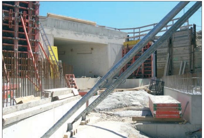
Der verlängerte Bahnsteigtunnel während des Baues
