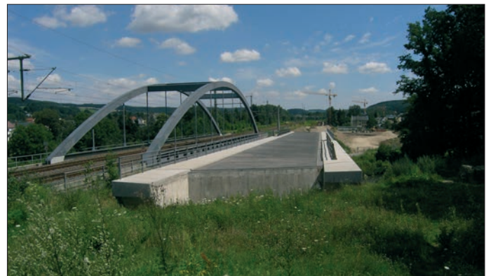
Die Spannbetonbrücke ist fertig gestellt. Noch fehlt die Straße.
