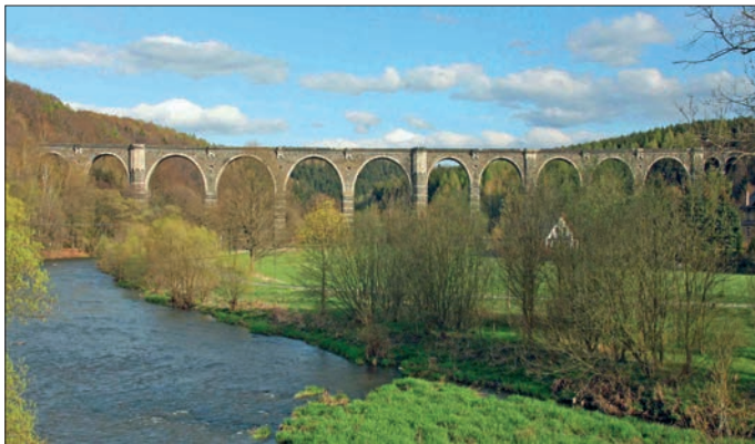
Der Hetzdorfer Viadukt, einer der bedeutendsten Kunstbauten der ersten Jahrzehnte der deutschen Eisenbahngeschichte.
