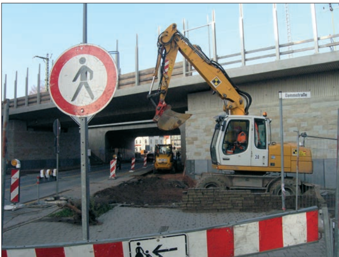
Die Straßenbrücke ist bald fertig. Im Hintergrund die Eisenbahnbrücke
