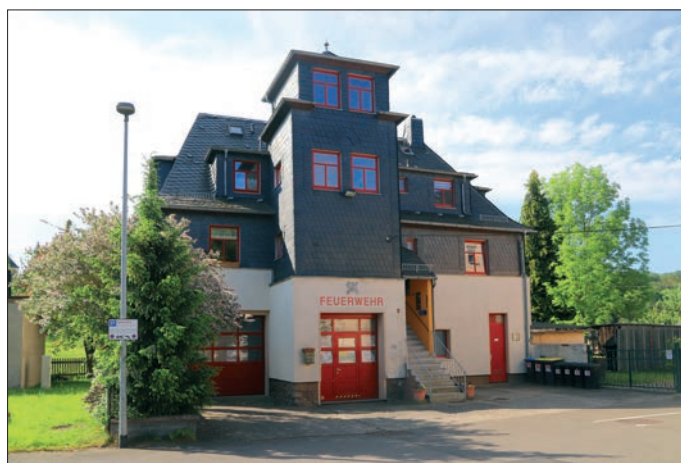
Das ehemalige Gerätehaus der Feuerwehr Falkenau in der Flöha-Aue, errichtet im Jahr 1922 und in den Jahren 1994/95 umfassend rekonstruiert. Es versah seinen Dienst bis in das Jahr 2015.
