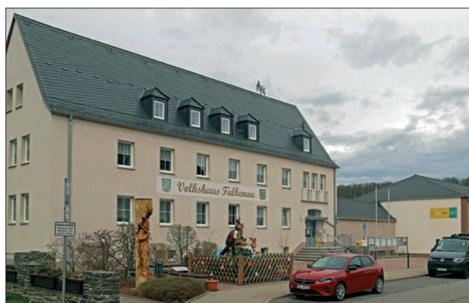
... und nach der umfassenden Sanierung
