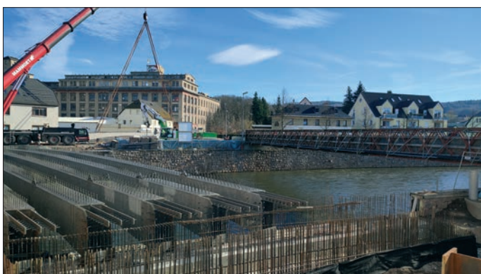
Während der Bauphase- im Hintergrund die Hilfsbrücke für Fußgänger
