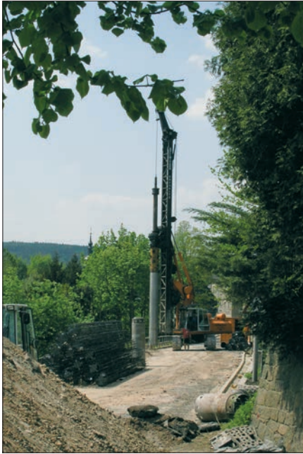
Tiefe Kernbohrungen wurden eingebracht
