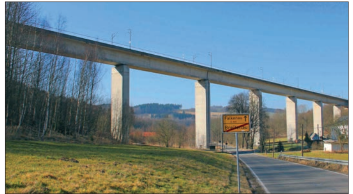
Durch eine 1987 bis 1992 erbaute geradlinige Neubaustrecke mit zwei modernen Talbrücken konnte der von zunehmenden Verschleißerscheinungen betroffene Hetzdorfer Viadukt außer Dienst gestellt werden. Im Bild die Talbrücken über die Flöha (oben) und den Hetzbach (unten).
