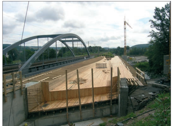
Die Holzwanne für die Betoneinbringung ist gebaut
