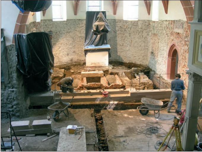
Blick in den Chorraum mit den freigelegten Grüften.
