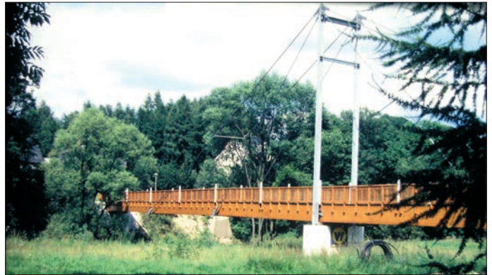
Die dritte Stegbrücke 1996 – 2023
