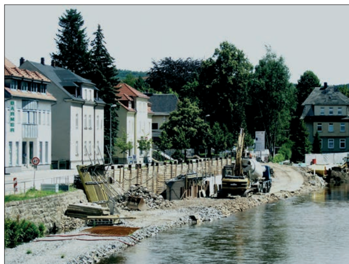
Die Baustraßen in der Zschopau
