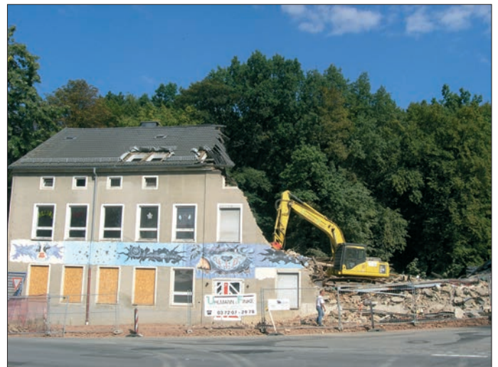
Der Abriss des Gasthofes ist im vollen Gang Ufo
