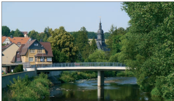
Die Kirchenbrücke 2021 mit schlankem Mittelpfeiler
