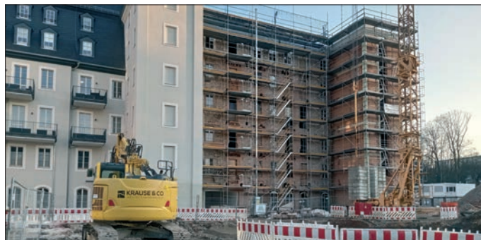
Der Altbau von 1826 Bauzustand März 2024
