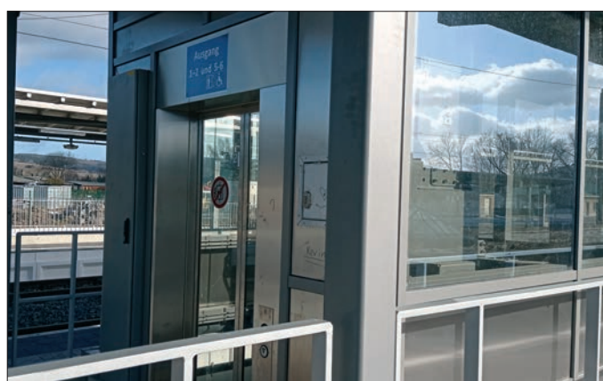
Der von dem Bahnsteig her sichtbare Teil der Personenaufzugsanlage
