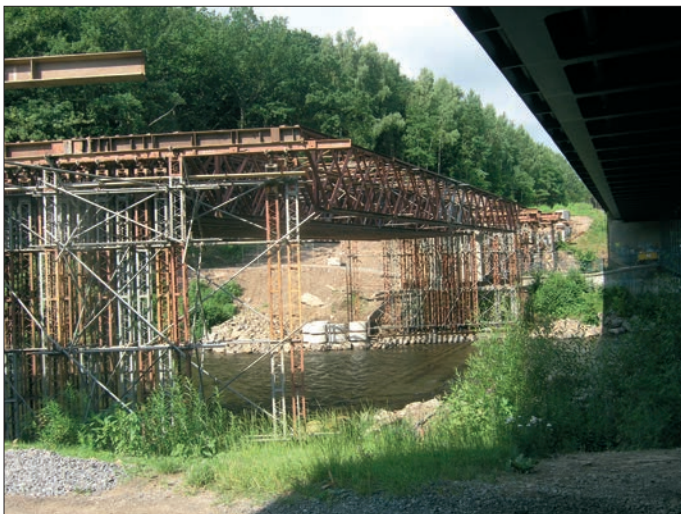
Der Unterbau für die Spannbetonbrücke
