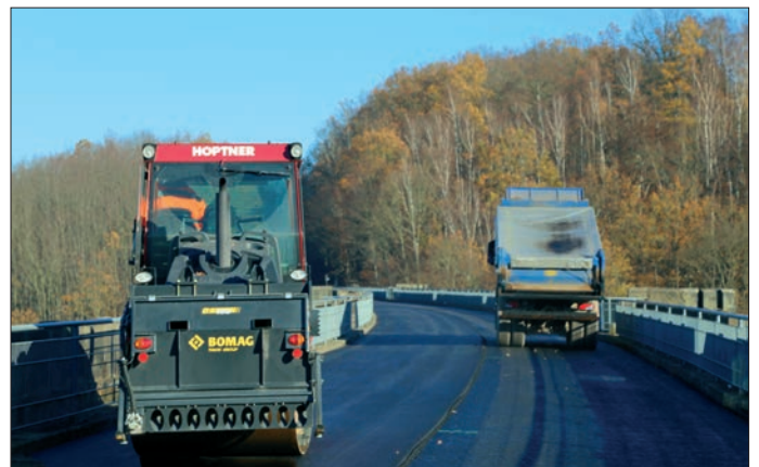
Im Herbst 2018 wurde das Pflaster mit Betonformsteinen auf der Brückenkronen durch eine Asphaltsschicht ersetzt.
