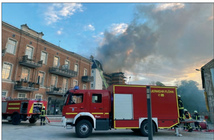
Dachstuhlbrand des 1826er Gebäudes in der „Alten Baumwolle“ am 02.05.2024 Colin Auerbach FFW Flöha
