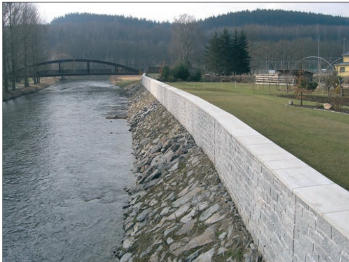
Die Ufermauer der Flöha unterhalb der Kirchenbrücke
