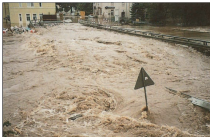
Die Behelfsbrücke verschwindet gerade im Wasser
