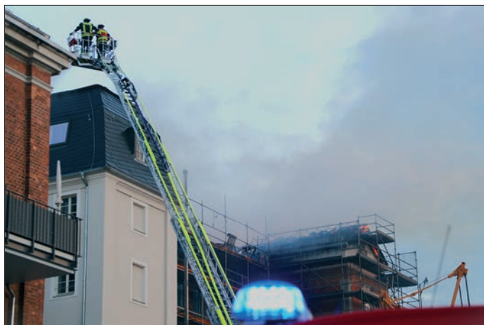
Am 02. Mai 2024 brannte der Dachstuhl des Altbaus 1826 in der Alten Baumwolle. Foto: Stadtverwaltung Flöha/ Erik Frank Hoffmann
