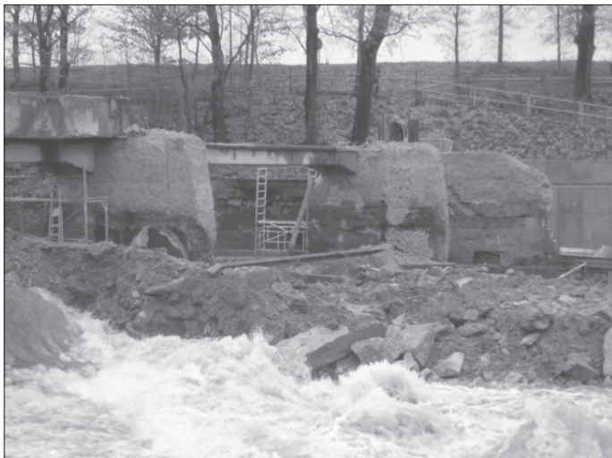
Sanierungsbeginn mit Abriss der maroden Bausubstanz im November 2007
