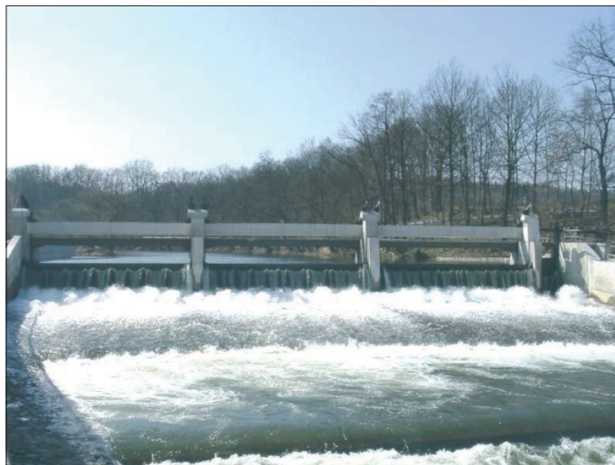
Erster Probestau im Dezember 2008. Die Stauanlage funktioniert einwandfrei und zeugt von der hervorragenden Arbeit von Projektant KTI Chemnitz und den beauftragten Bauunternehmen.
