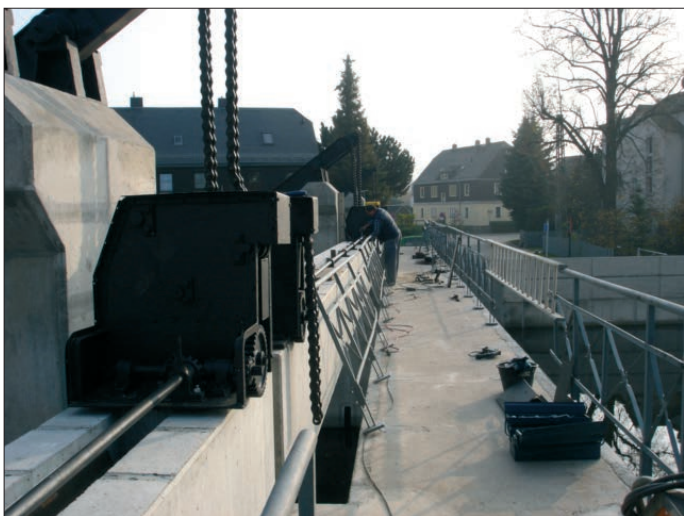
Die Montage der Antriebe und Aufhängungen der Wehrklappen sowie des Geländers vom Bediensteiges nach denkmalgerechter Rekonstruktion in November 2008. Seit 2013 ist der Bediensteg von März bis November für Fußgänger von 6-22 Uhr geöffnet
