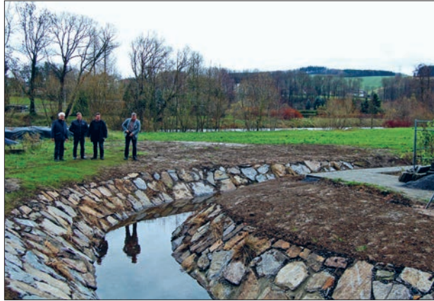
Der offengelegte Schieferbach im Ortsteil Falkenau am Tag der Abnahme der Baumaßnahme durch die Stadtverwaltung Flöha. Foto: A. Stefan
