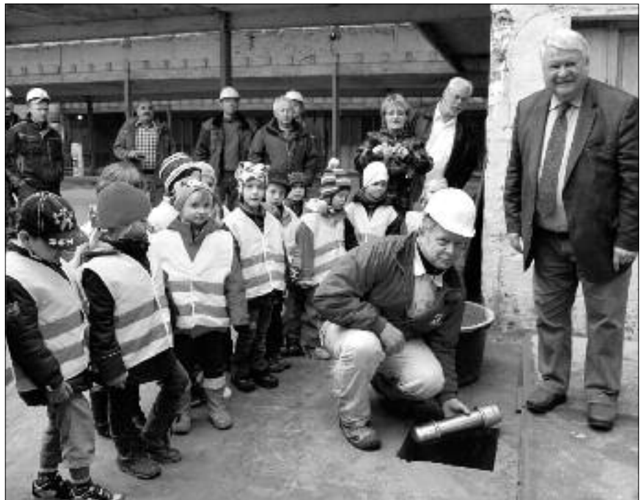
Unter den staunenden Augen der Kinder legten Oberbürgermeister Friedrich Schlosser (r.) und Vorarbeiter Frank Schöniger von der Hoch- und Tiefbau Rochlitz GmbH eine sogenannte Zeitkapsel, gefüllt mit einer Tageszeitung, einem aktuellen Amtsblatt und einer Serie EURO-Münzen in das Fundament zur zukünftigen Kindereinrichtung.
